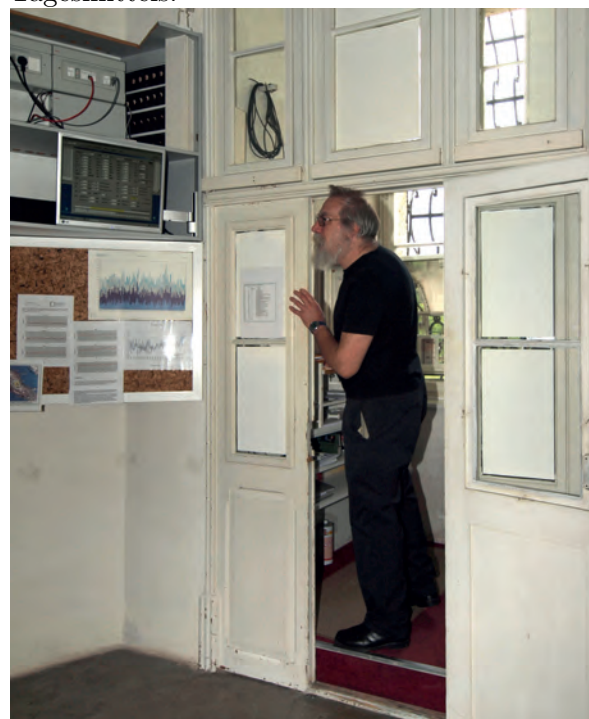
Abb. 8 Das historische Wetterkammerl im 1. Stockwerk der Sternwarte mit moderner Datenanzeige der TAKLIS
