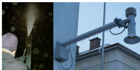
Abb. 4 Vereisungstest: Besprühen der Anlage (links) und der Schneehöhensensor nach erfolgter Vereisung (rechts).
