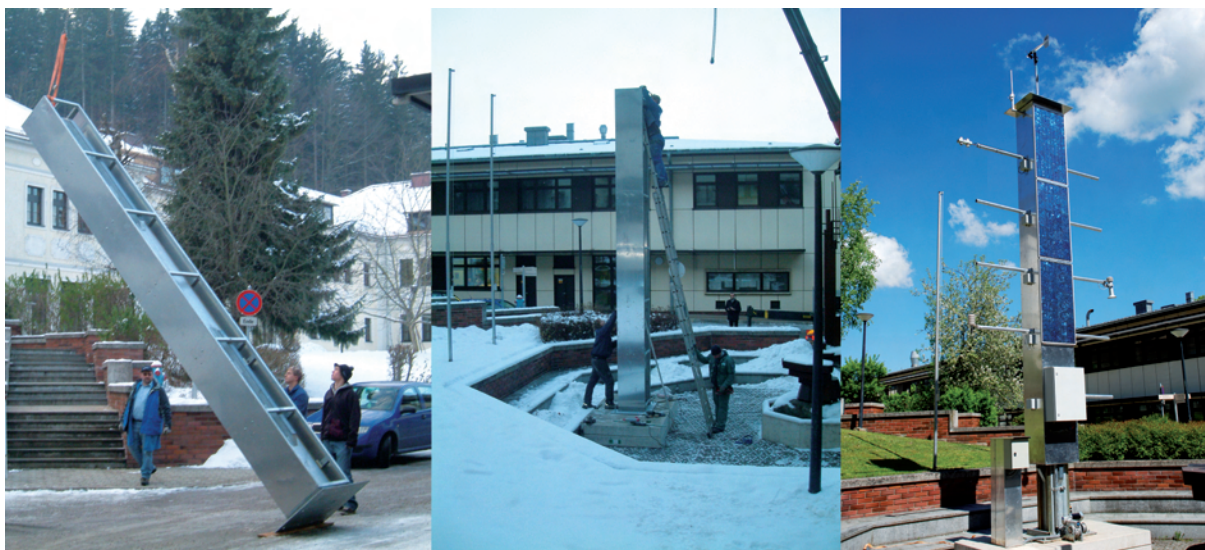
Abb. 3 Aufstellen des Rohgerüsts von METLIFT mittels LKW-Kran (links). Die Montage erfolgte auf zwei Betonplatten (Mitte). Rechts: Testinstallation von METLIFT am Standort HTL Waidhofen/Ybbs. Der Lift ist um ca. 1 m ausgefahren (rechts).
