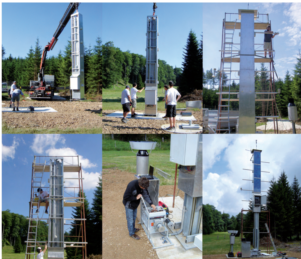
Abb. 6 Aufstellen des Liftes am Traflberg. Der Lift wird an seinen Bestimmungsort verbracht und auf die im Fundament eingegossenen Gewindestangen gesetzt. Aufrüstung des Liftes: Anbringung der Seitenarme und der Strahlungssensoren, erste Funktionstests der Liftsteuerung und letzte Funktionstests, der Lift ist vollständig ausgefahren.
