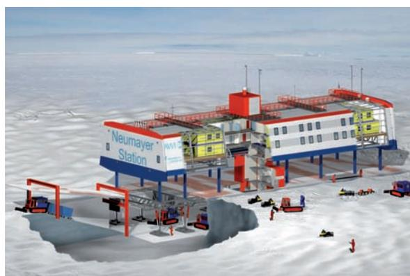
**Abb. 3:** Neumayer III ist ein kombiniertes Gebäude für Forschung, Betrieb und Wohnen auf einer Plattform oberhalb der Schneeoberfläche mit einer in den Schnee gebauten Garage.
